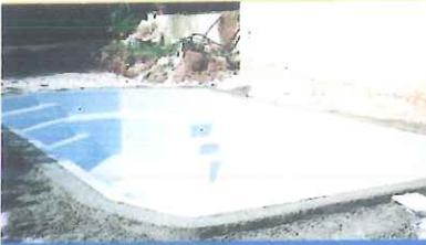
Ausführung des Betongürtels
